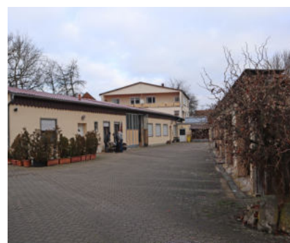
Stark versiegelte rückwärtige, private Bereiche
