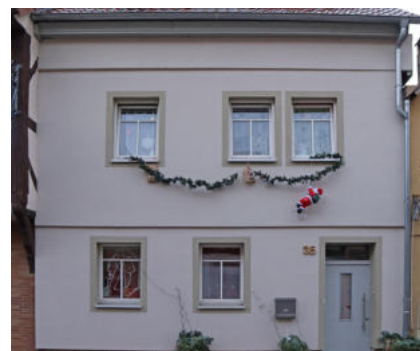
Gebäudezustand sehr gut: Altbau saniert, Veit-Stoß-Straße
