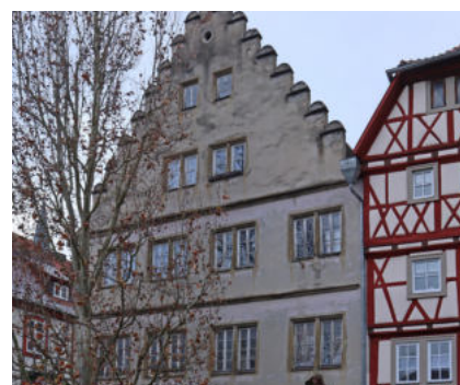
Schlechter Gebäudezustand, Veit-Stoß-Straße
