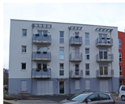
Gebäudezustand sehr gut: Neubau, Am Dicken Turm
