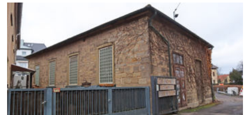
Bestandssituation Alte Turnhalle
