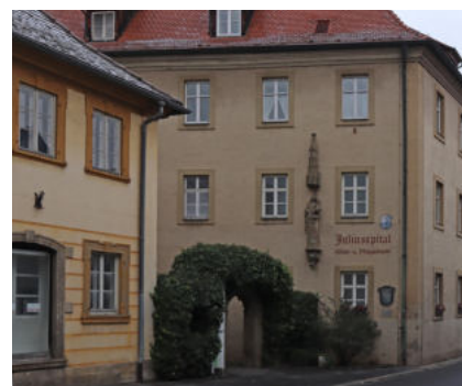
Seniorenheim Juliusspital, Riemenschneiderstraße
