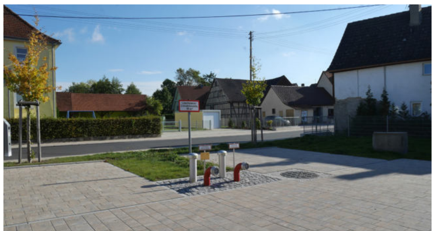
Parkplatz mit E-Ladestation und Löschwasserentnahmestelle am Ortszentrum
